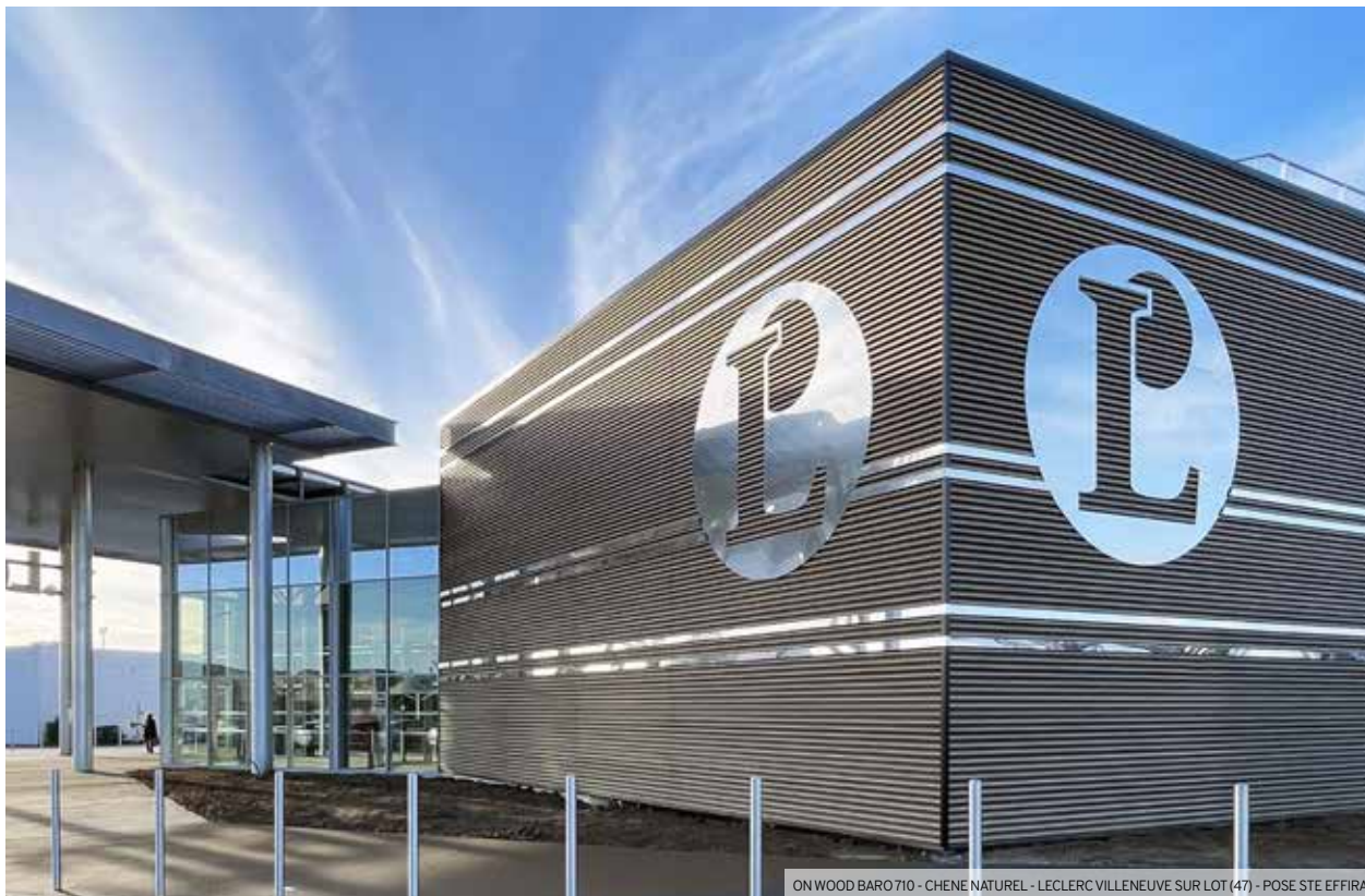
ON WOOD BARO 710 - CHENE NATUREL - LECLERC VILLENEUVE SUR LOT (47) - POSE STE EFFIRA
