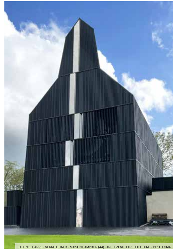
CADENCE CARRE - NERRO ET INOX - MAISON CAMPBON (44) - ARCHI ZENITH ARCHITECTURE - POSE AXIMA
