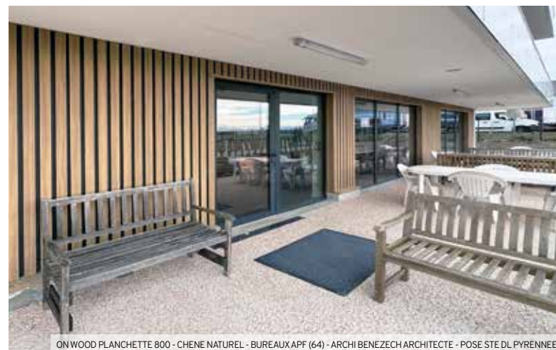
ON WOOD PLANCHETTE 800 - CHENE NATUREL - BUREAUX APF (64) - ARCHI BENEZECH ARCHITECTE - POSE STE DL PYRENNEES
