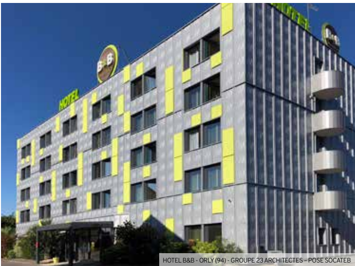
HOTEL B&B - ORLY (94) - GROUPE 23 ARCHITECTES - POSE SOCATEB
