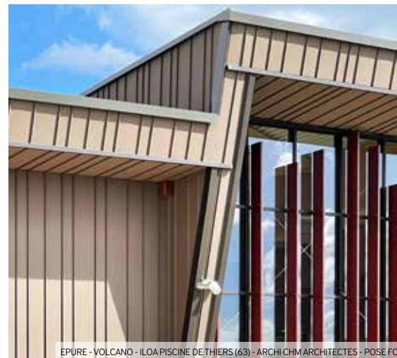
EPURE - VOLCANO - ILOA PISCINE DE THIERS (63) - ARCHI CHM ARCHITECTES - POSE FCI
