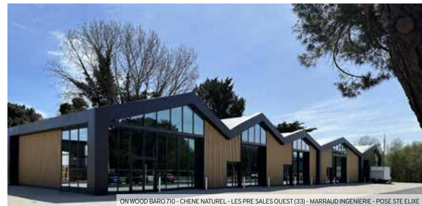
ON WOOD BARO 710 - CHENE NATUREL - LES PRE SALES OUEST (33) - MARRAUD INGENIERIE - POSE STE ELIXE
