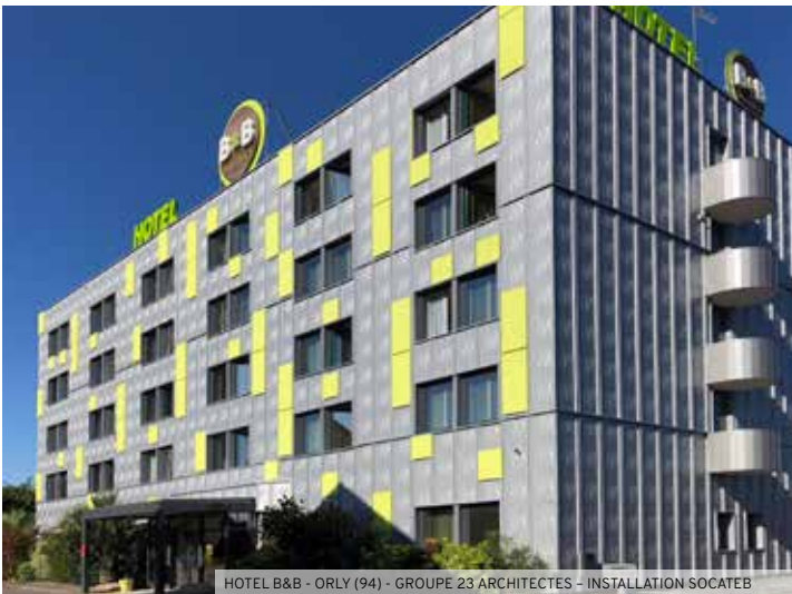
HOTEL B&B - ORLY (94) - GROUPE 23 ARCHITECTES - INSTALLATION SOCATEB
